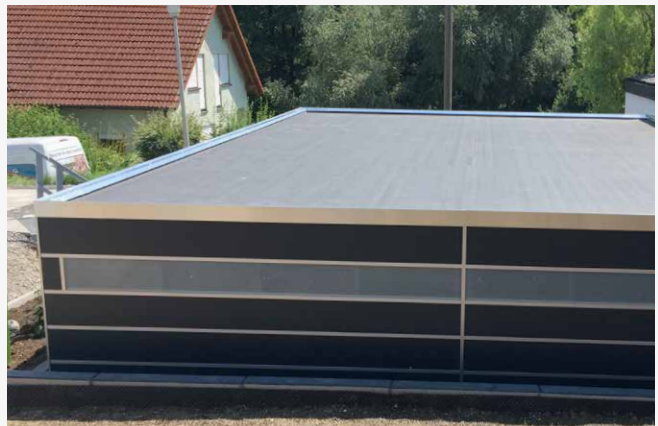
Dach aus EPDM-Membrane
