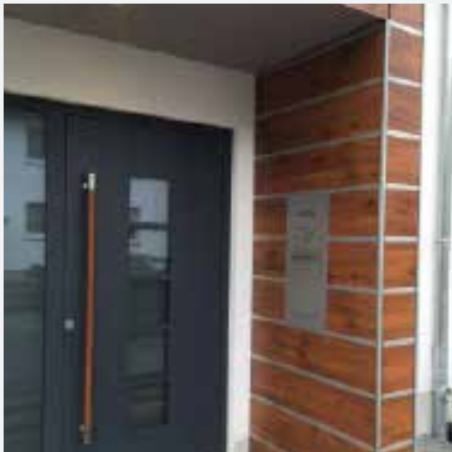
Haustürüberdachung Fundermax Kiefer Tirol mit VA-Briefkasten
