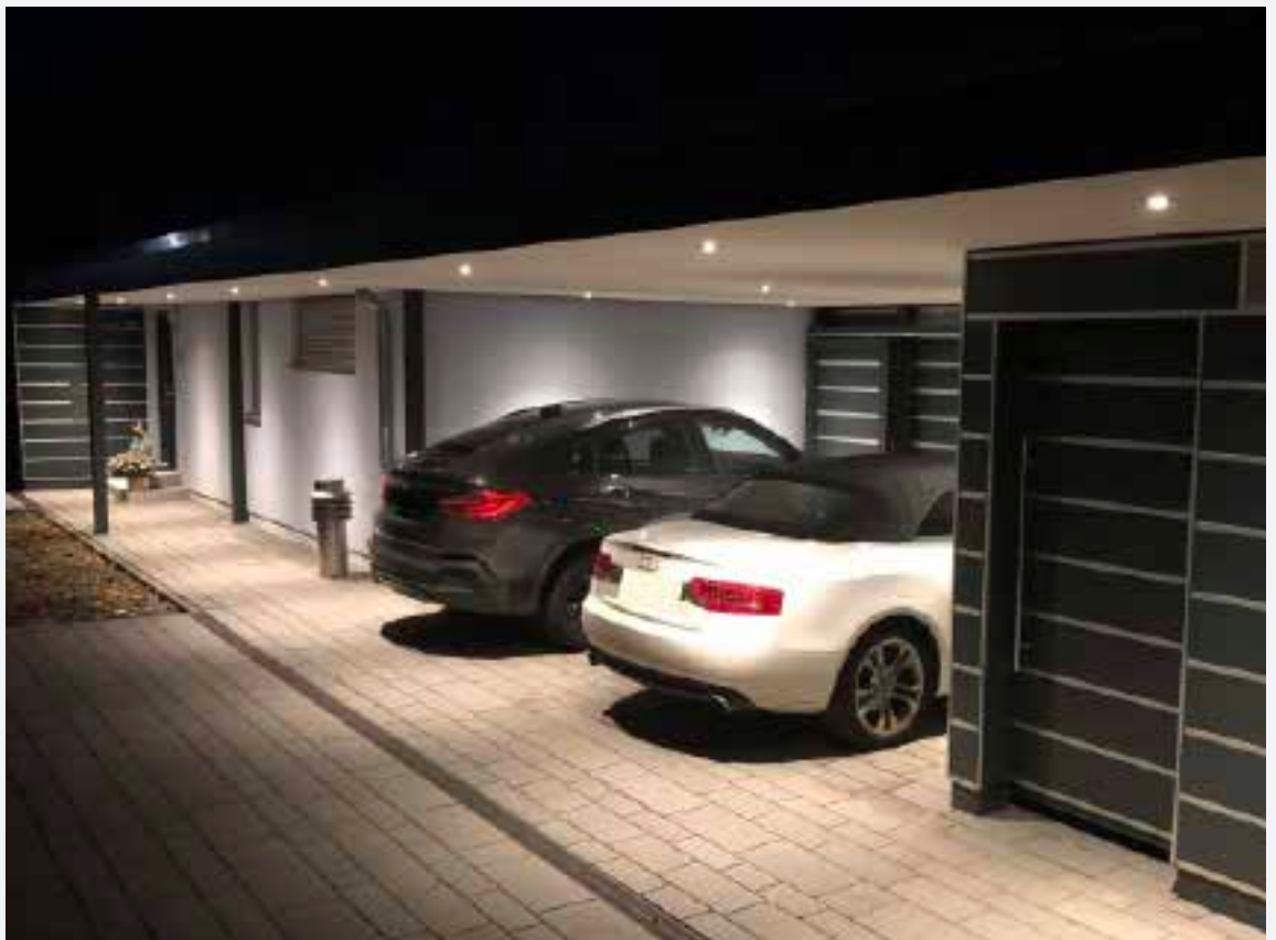
Carport HPL mit Abstellraum, Briefkasten, verkleideter Decke und großen LEDs
