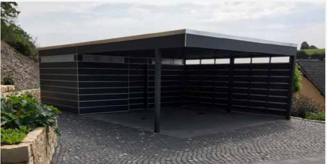
Carport HPL mit Abstellraum und Seitenwand
