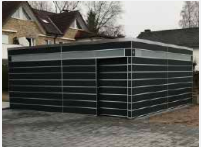
Abstellraum HPL mit großer Schiebetür und Lichtband
