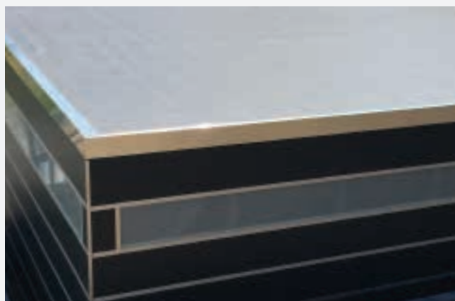
Dach-Wetterseite aus EPDM-Membrane
