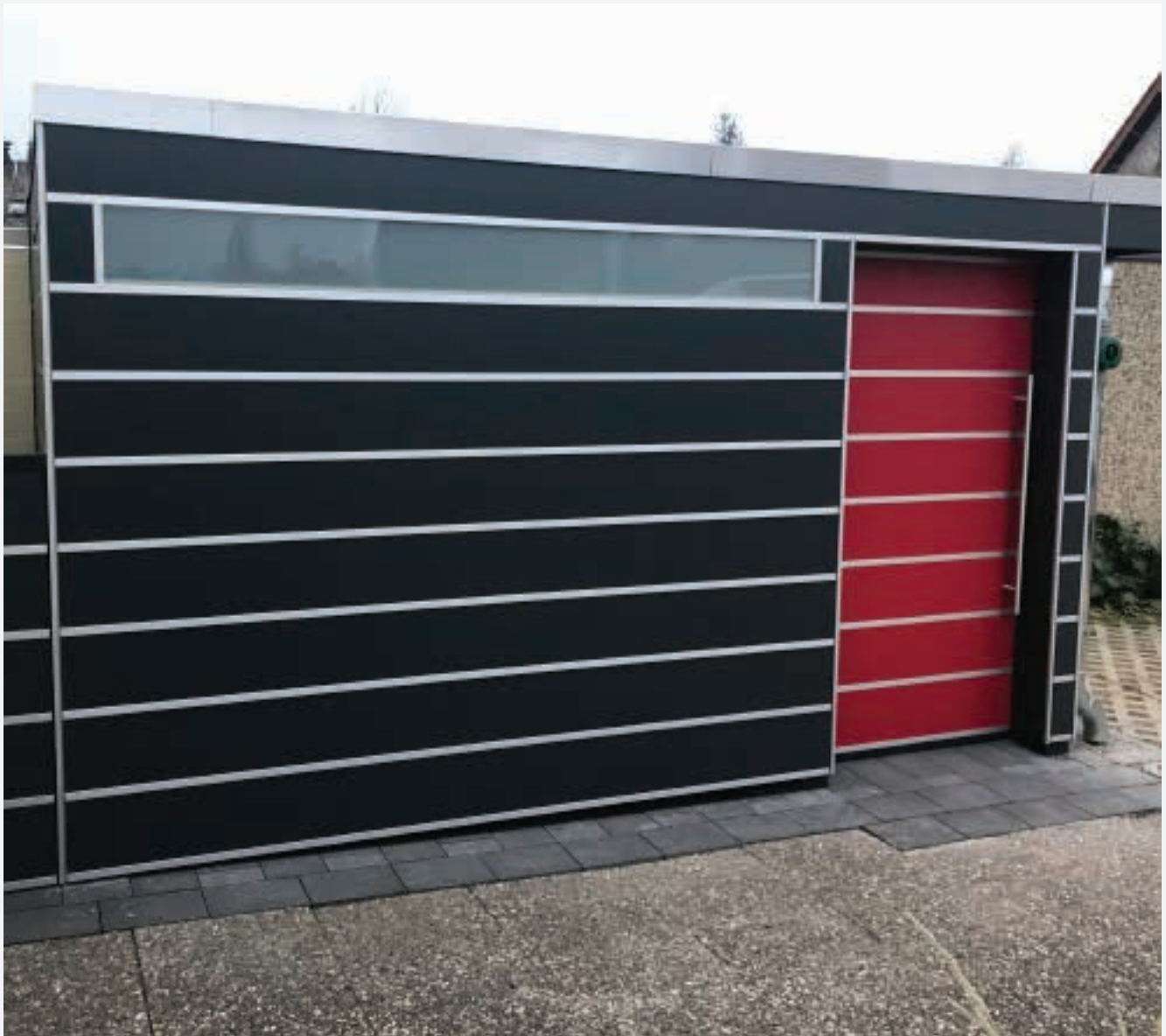
Abstellraum HPL in anthrazit mit einer Schiebetür in karminrot
