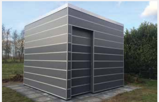
Abstellraum / Flachdach Bauhaus Trespa® 2 farbig in Grau
