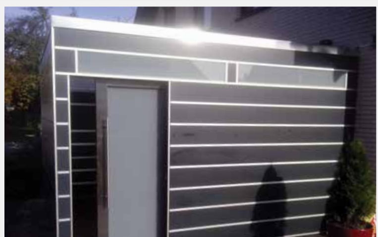
Abstellraum / Flachdach Bauhaus Trespa® Schiebetür in Edelstahlverkleidung mit Milchglasfüllung
