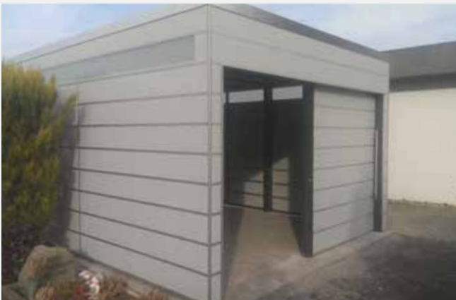
Abstellraum / Flachdach Bauhaus Trespa® mit Schiebetür und Lichtelement
