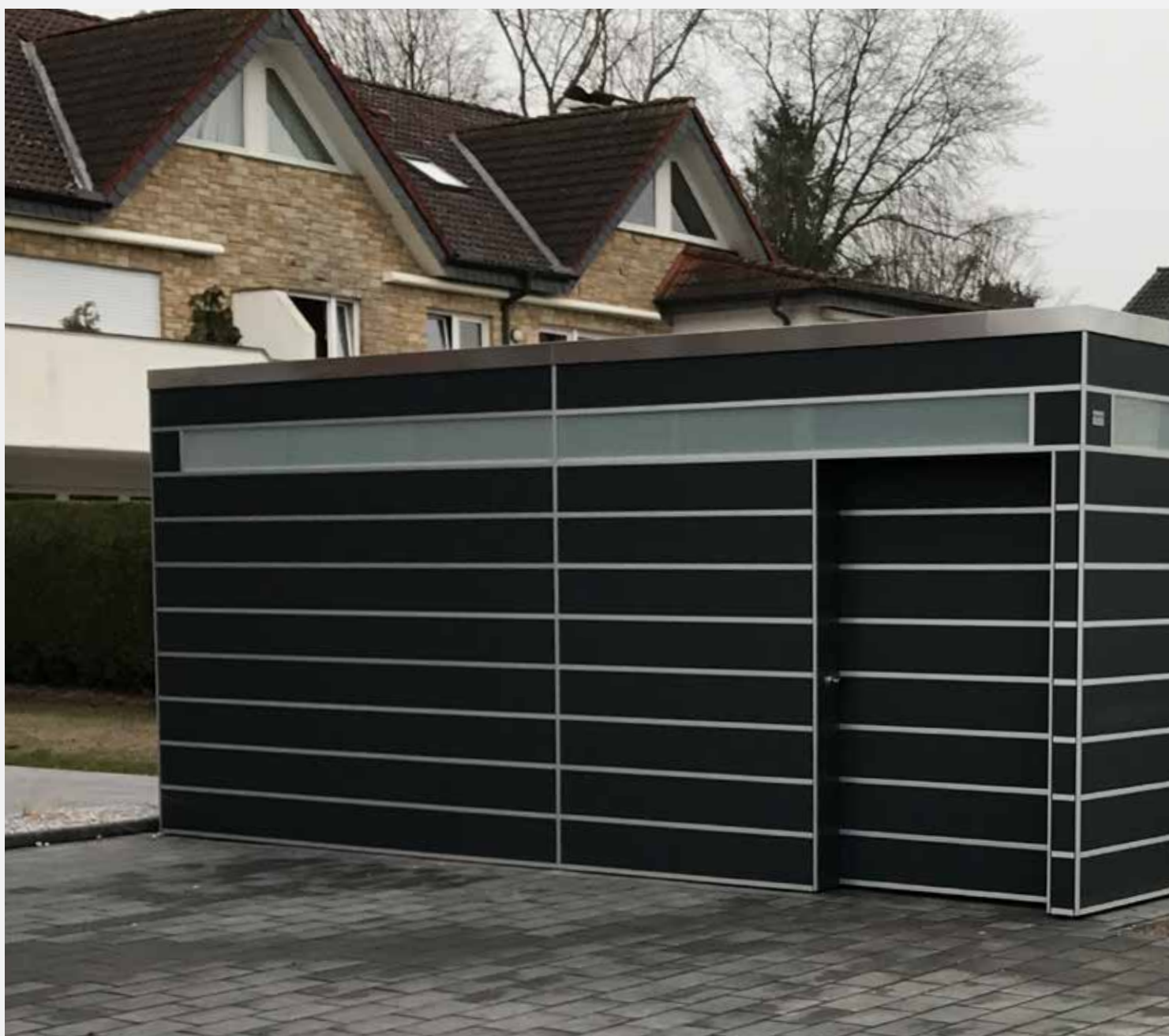
Abstellraum / Flachdach Bauhaus Trespa® HPL Platte 8 mm mit Twin Top Profilen und Milchglaslichtelement
