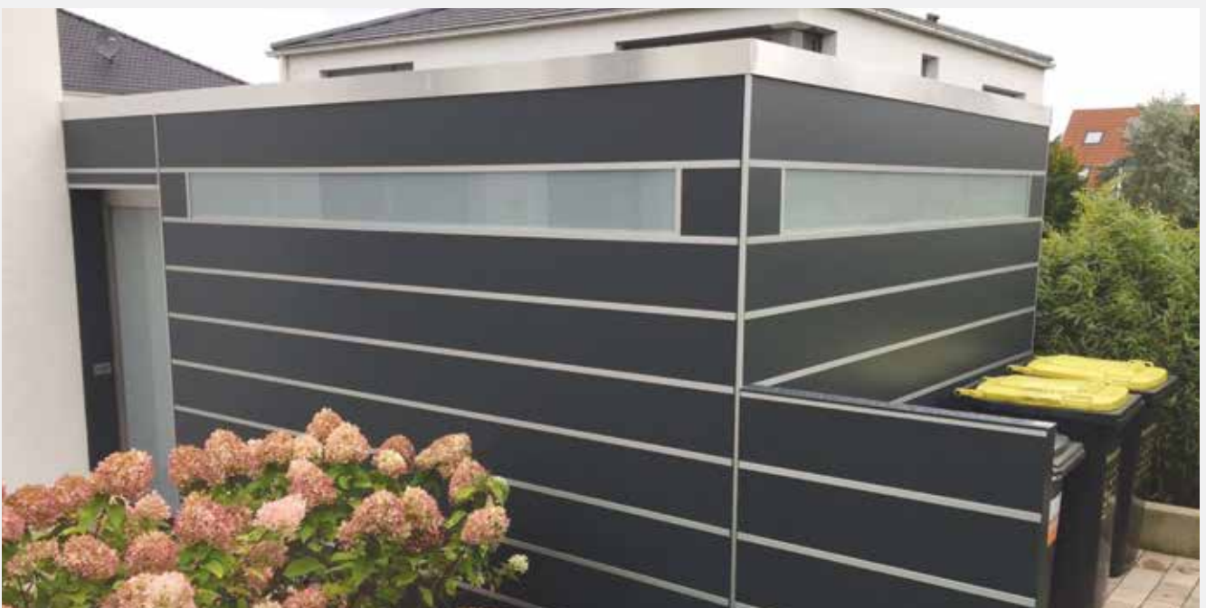
Abstellraum / Flachdach Bauhaus Trespa® mit Lichtband und Schiebetür in Edelstahlverkleidung mit Milchglasfüllung
