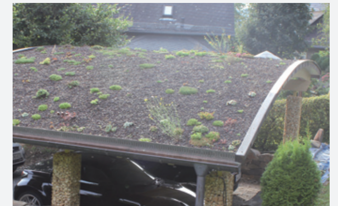
Dach-Wetterseite aus EPDM-Membrane, Optional: Gründach
