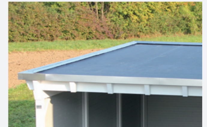
Dach-Wetterseite aus EPDM-Membrane
