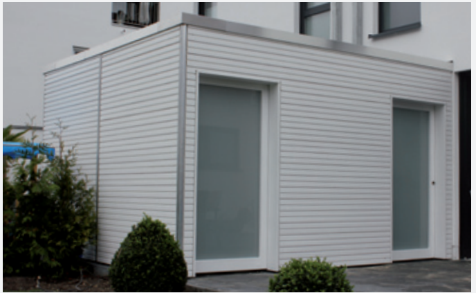
Abstellraum Bauhaus Rhombo Schiebetüren mit Milchglasfüllung
