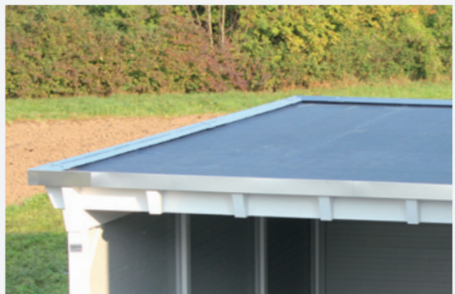
Dach-Wetterseite aus EPDM-Membrane,
