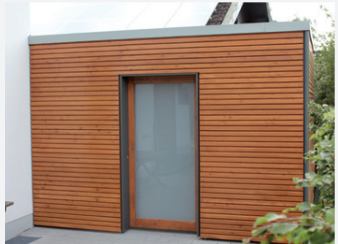
Abstellraum Bauhaus Rhombo Schiebetür mit Milchglasfüllung Aluminium-Ecken anthrazit; Sonderwunsch
