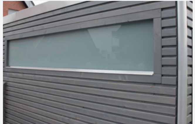
Abstellraum Bauhaus Rhombo Fensterelement mit Milchglasfüllung
