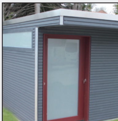
Fensterelement, Aluminium-Blende und Überdach, Schiebetür mit Milchglasfüllung
