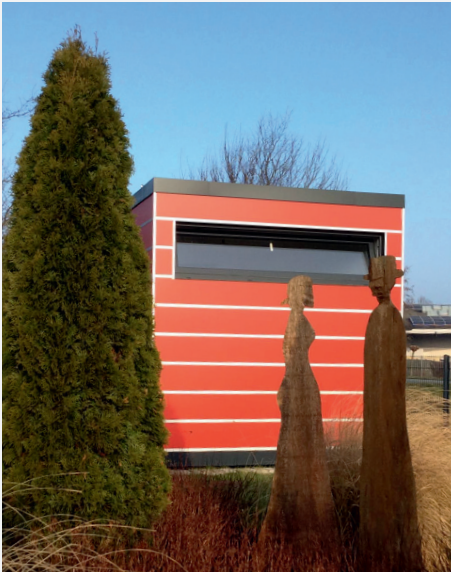
Boxx III / Flachdach Bauhaus HPL-Trespa® mit kaminroten Trespa Platten und Dachrandblenden in anthrazit.
